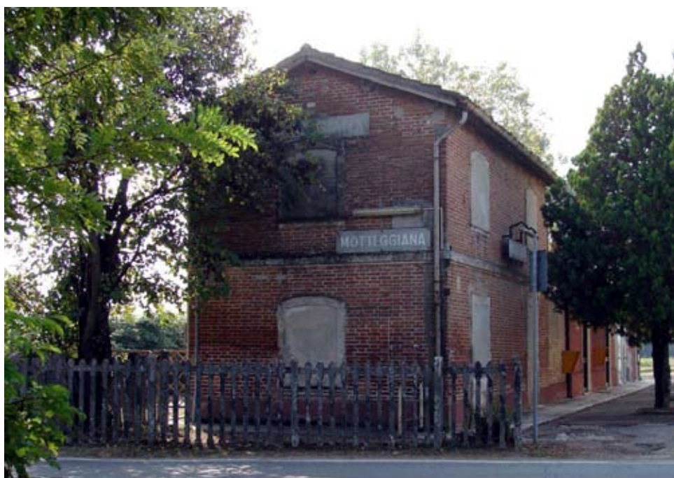
Stazione ferroviaria di Motteggiana
